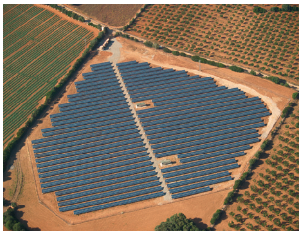
Die auf Mallorca in der Nähe von Lluçmajor errichtete Anlage produziert jährlich rund 3 Mio. Kilowattstunden Solarstrom.
