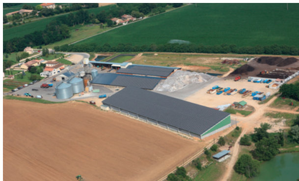
765 kW-Anlage Silos de la Sizeranne in Chatuzange-le-Goubet
