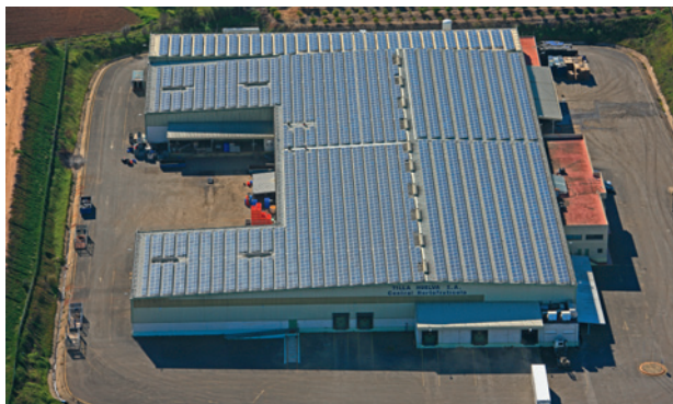
913 kW-Anlage Huelva in Gibralfuente
